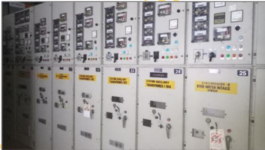
HT Switchgear
